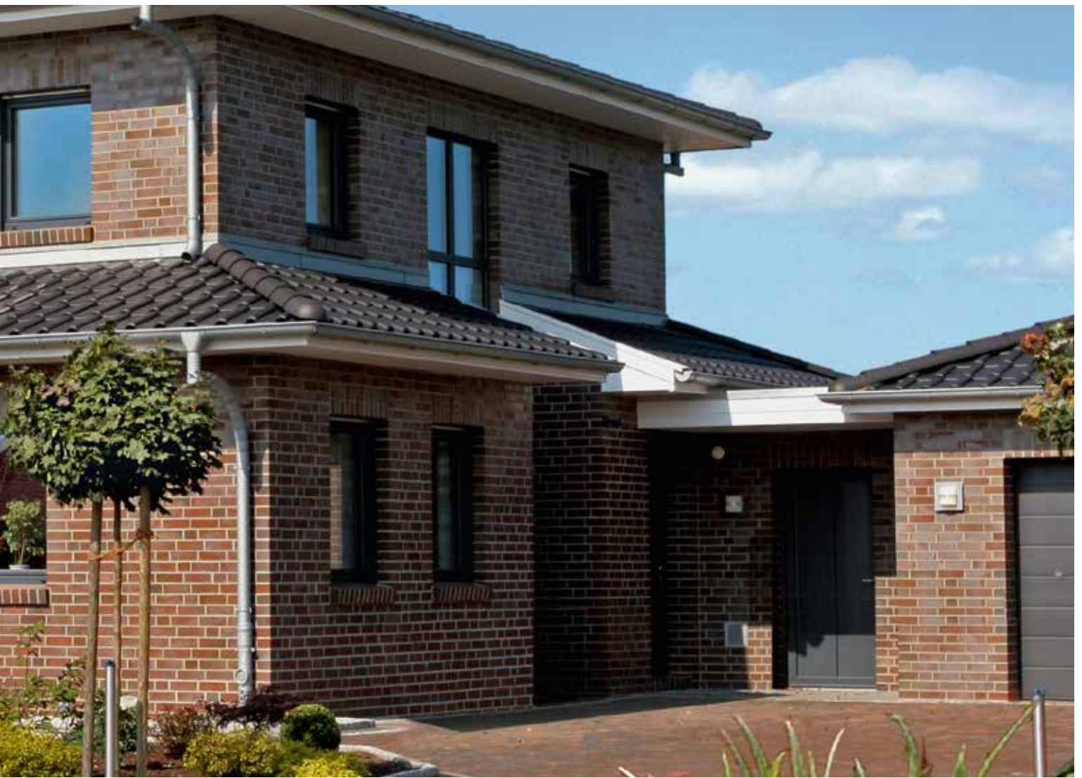
Röben Klinker ACCUM blau-braun, NF Dach: Röben Flachdachziegel FLANDERNplus, anthrazit
