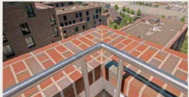
Ein Röben Fertigteil als präzise ausgeführte Mauerwerks-Abdeckung, individuell für das Objekt vom Röben PlanungsService entwickelt und produziert. Hier als Balkon-Brüstung mit drei Sichtseiten.
