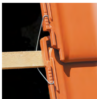
Die Fixierungskerben für die Sturmklammern.
