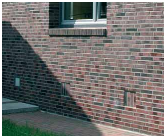
Energetische Gebäudesanierung mit Wärmedämmung und Verblendmauerwerk.
