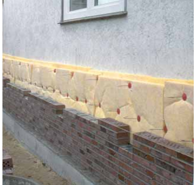
Energetische Gebäudesanierung mit Wärmedämmung und Verblendmauerwerk.
