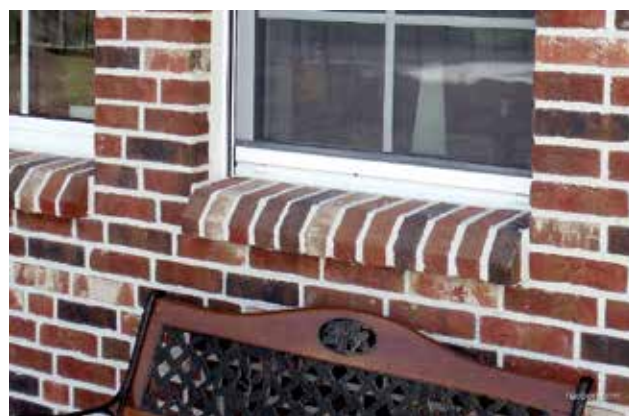
Beispiel für eine Fensterbank-Rollschicht mit Wärmedämmung
