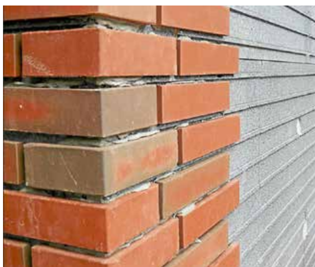
Die hohe Maßhaltigkeit der Röben Klinkerriemchen und der perfekte Winkel der Eckriemchen erleichtern die Montage im Fugenleitsystem
