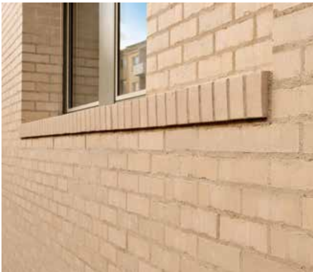
Bündig abgezogene, nicht zusätzlich verdichtete Mörtelfugen.
