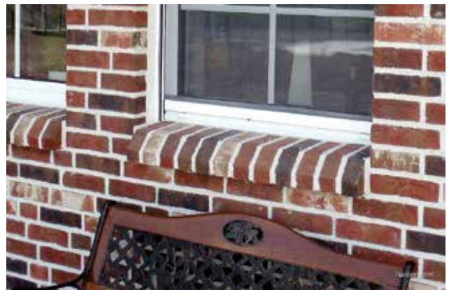
Beispiel für eine Fensterbank-Rollschicht mit Wärmedämmung
