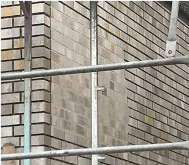
Fläche mit Probefugen für den LYON blaugrau.
