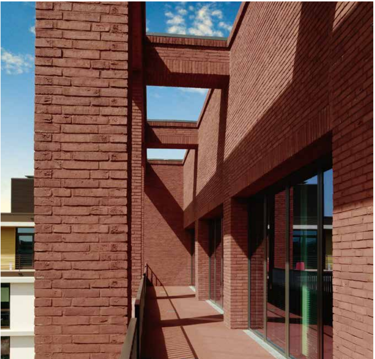
Bürogebäude mit klarer Formensprache: Der Röben Handform-Verblender WIESMOOR mit rotem Fugenmörtel.
