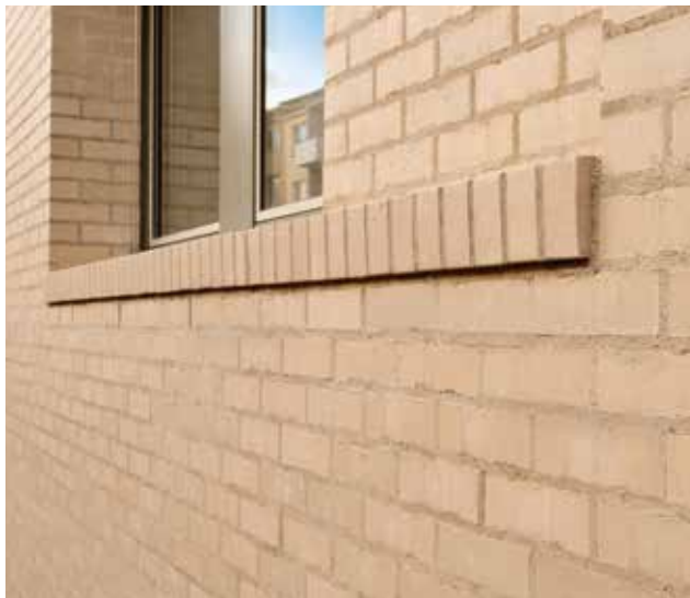
Bündig abgezogene, nicht zusätzlich verdichtete Mörtelfugen.
