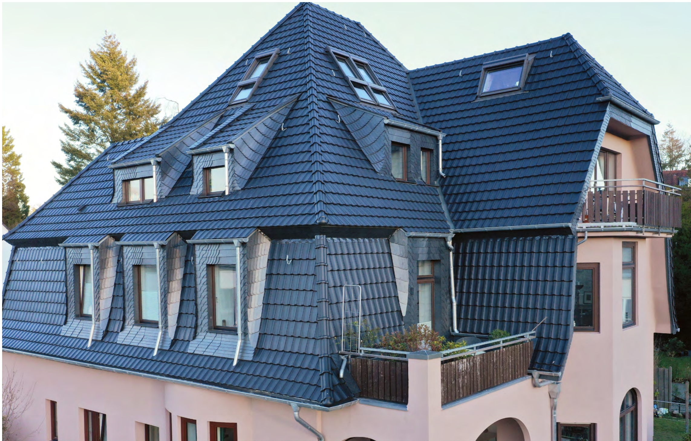
Das Dach vor der Sanierung
