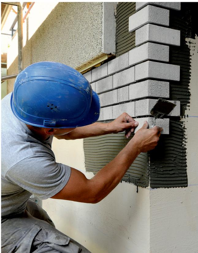
Die Ausführung der Riemchenbekleidung erfolgt nach DIN 18 515-1. Es ist darauf zu achten, dass alle zulassungsrelevanten Produkte systemkonform verwendet werden. Die Verlegung der Riemchen erfolgt stets im kombinierten Verfahren nach DIN EN 12 004.
