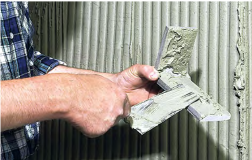
Kleberauftrag im kombinierten Verfahren („Floating-Buttering“)
