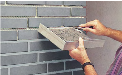
Sauberes Verfugen mit Fugeisen und Fugblech
