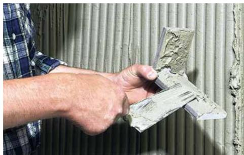
Kleberauftrag im kombinierten Verfahren („Floating-Buttering“)
