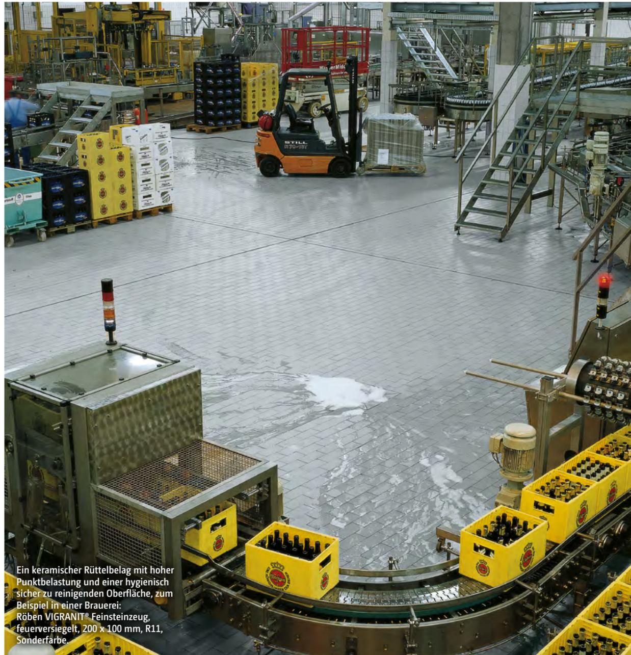
Ein keramischer Rüttelbelag mit hoher Punktbelastung und einer hygienisch sicher zu reinigenden Oberfläche, zum Beispiel in einer Brauerei:
