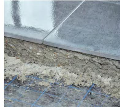
Beispiel für einen Bodenaufbau im Verbund.
