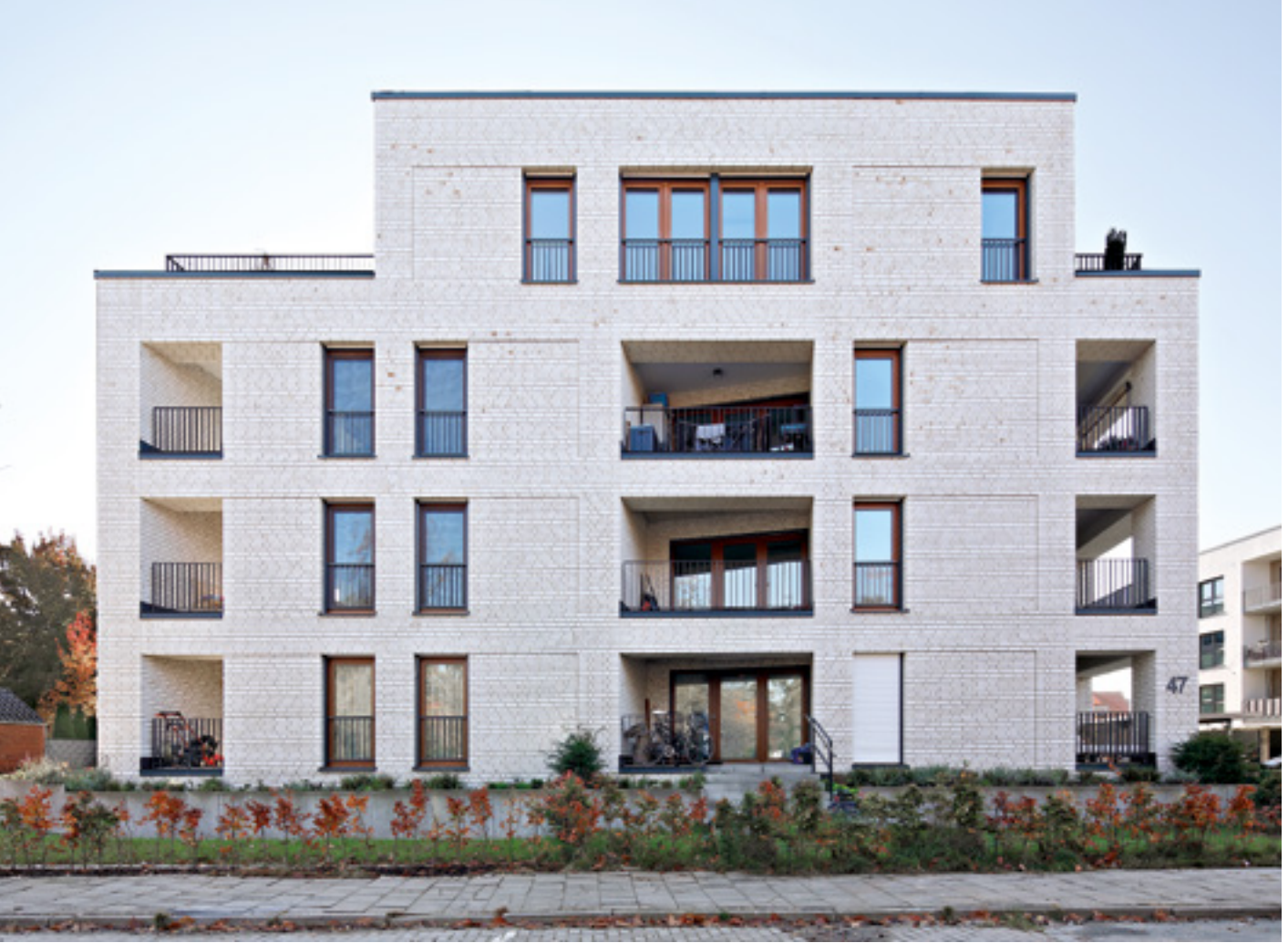
■ Auf Höhe der Fenster wurden die Fassadenflächen zum Teil als „Schattenmauerwerk“ leicht zurückgesetzt, um eine plastische Gliederung der Fassaden zu erzielen.
