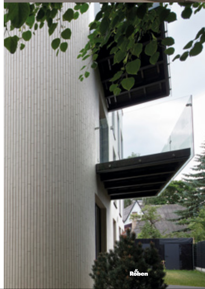
■ Eine Besonderheit der Fassade ist die vertikale Verarbeitung der schmalen Dünnformat-Riemchen.
