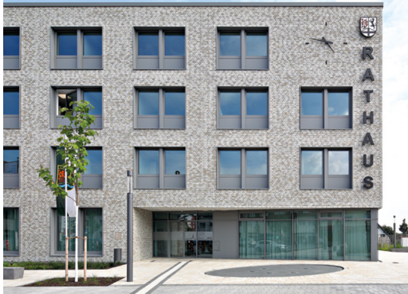
■ Die Ansicht nach Süden haben die Architekten mit einer im Erdgeschoss zurückspringenden Eingangsfront hervorgehoben.
