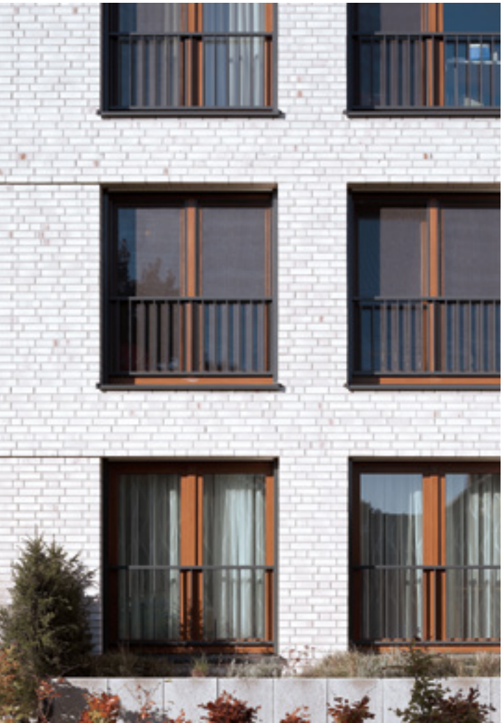
■ Auf Höhe der Fenster wurden die Fassadenflächen zum Teil als „Schattenmauerwerk“ leicht zurückgesetzt, um eine plastische Gliederung der Fassaden zu erzielen.
