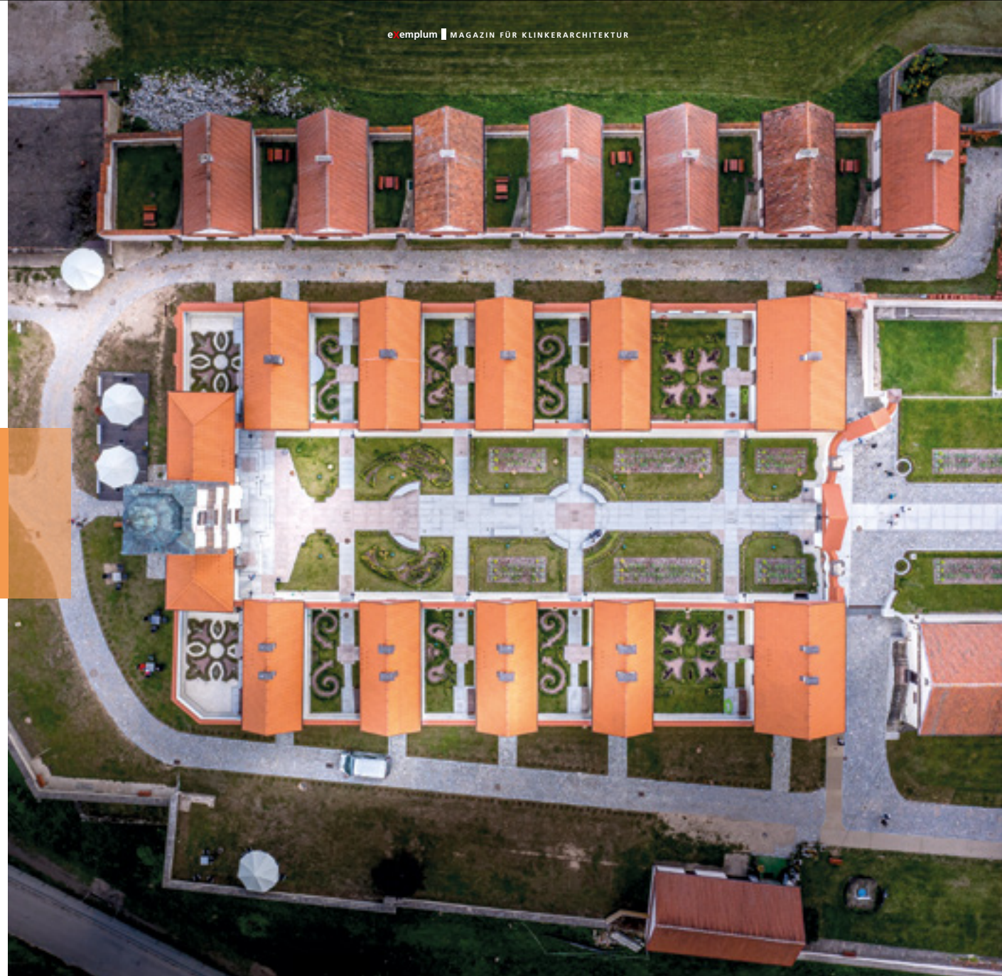
■ Aus der Vogelperspektive wird der Kontrast zwischen den alten und den neuen Dächern mit den neu eingedeckten Ziegeldächern deutlich.
