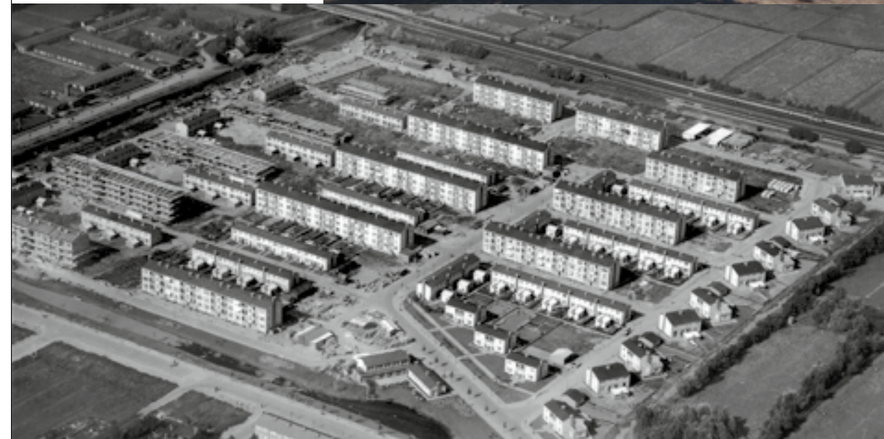
Der nach Osten neu eingefügte vier- bis fünfgeschossige Gebäudekomplex fungiert auch als Lärmschutz gegenüber der dahinter verlaufenden Autobahn.
