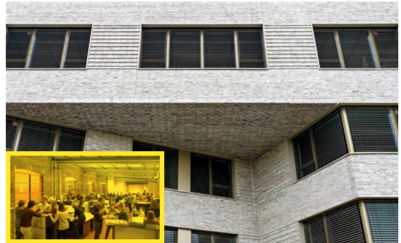
Die Unterseite der Auskragung wurde mit passenden Riemchen, der Übergang in die aufsteigende Fassade mit speziell gefertigten Läuferwinkeln gestaltet.
