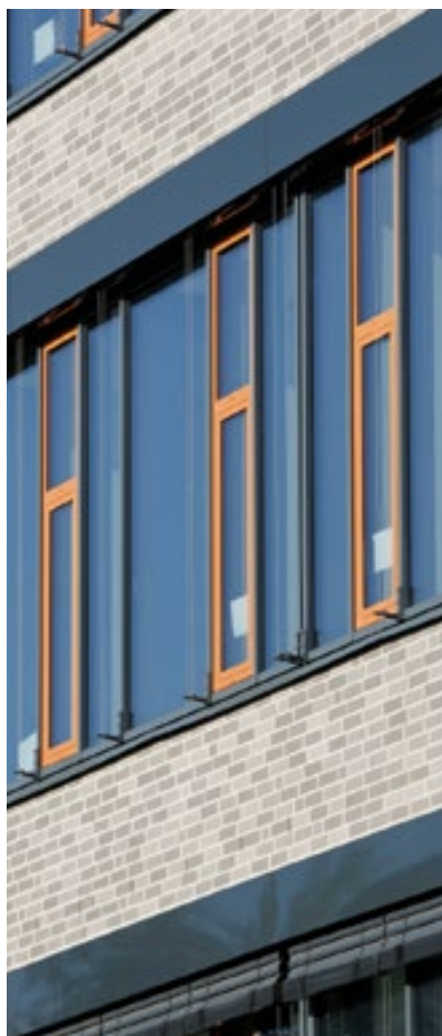
■ Charakteristisch für den Neubau ist das Zusammenspiel von langgestreckten horizontalen Fensterbändern mit durchgehenden Brüstungsbändern aus hellem Klinker.
