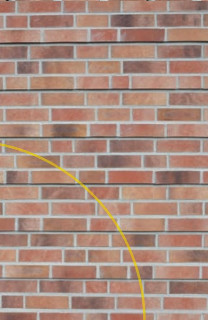
■ Schatten an der Wand: Die Stirnfassade hinter der Lärmschutzwand wurde als Akzentmauerwerk mit angedeuteten Fensterflächen und Fensterbänken realisiert.
