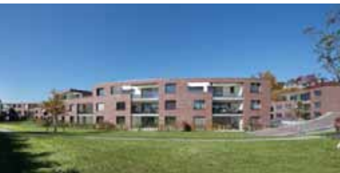
Elegant geschwungen - Wohnungsbau, Meggen (CH), Seite 14
