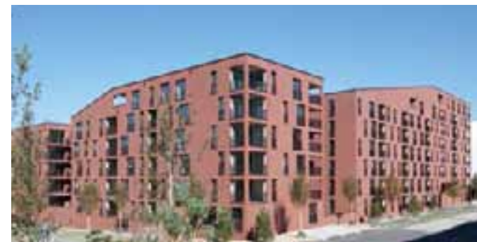
Souverän behauptet - Wohngebäude, Ebikon (CH), Seite 42
