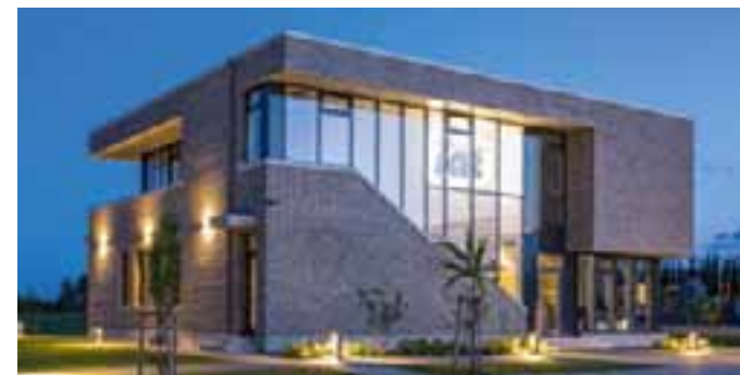
Wechselnde Ansichten - Bürogebäude, Uckerfelde, Seite 48
