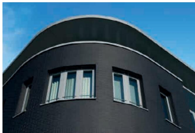
Saubere Rundung mit Röben Keramik-Klinker-Riemchen. Dahinter verbirgt sich ein modernes Wärmedämm-Verbundsystem.
