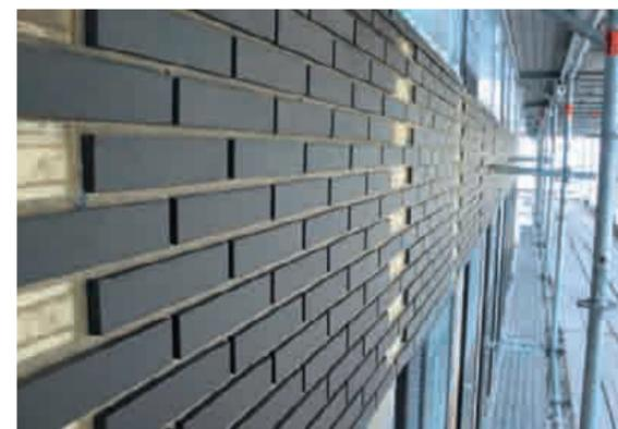
stern die handwerklich bedingten Abweichungen bei der Montage der vorgefertigten Dämmelemente im Mauerwerk weniger deutlich sichtbar“, so Joost Berger.
