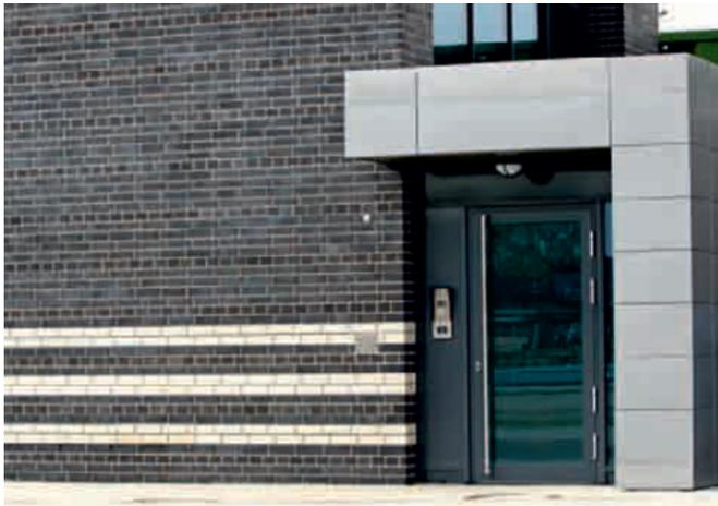
Die Klinkerschale wurde im sog. „Amerikanischen Verband“ gemauert. Auf eine Binderschicht folgen vier Läufer-schichten.
