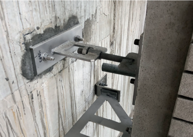
Über massive Fassadenanker werden die Fertigteilelemente am Bauwerk gehalten.
