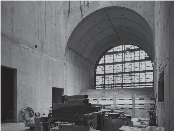
Imposant zeigten sich die neuen Museumsräume bereits im Rohbau.
