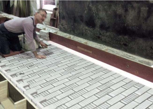
Auf großen Tischen wurden die Riemchen in der Werkshalle für das Ausgießen mit Beton vorbereitet.
