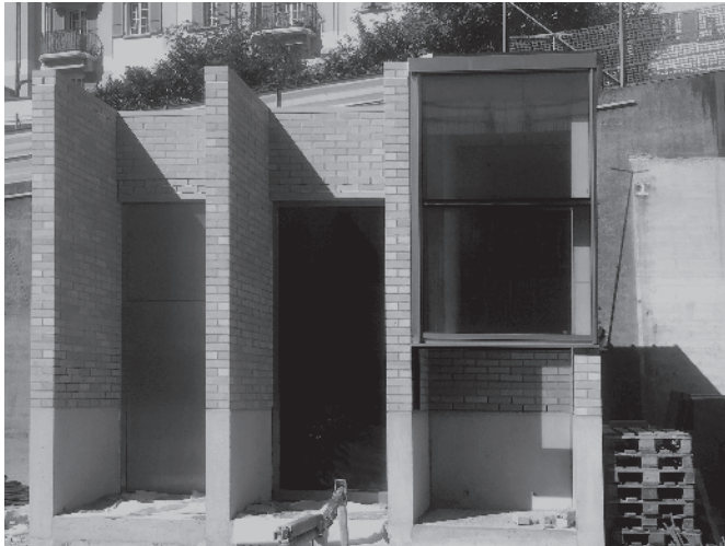
Anhand des aufwendig gefertigten Mock-ups trafen Architekten und Bauherren letzte Entscheidungen bezüglich der Ausführung.
