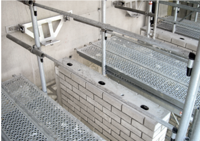
Jeder der 84 schlanken Pilaster zeugt von absoluter Präzisionsarbeit auf der Baustelle.
