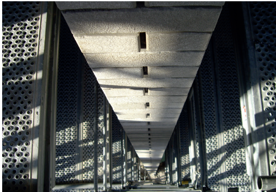
Die haushohen Pilaster des Musée cantonal des Beaux-Arts wurden aus je vier exakt konstruierten Ziegel-Fertigteilelementen hergestellt.
